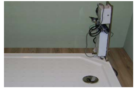
Instalovat generátor install the generator
