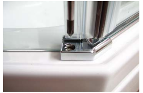
Použít šrouby 3,5x16 use screws 3,5x16
