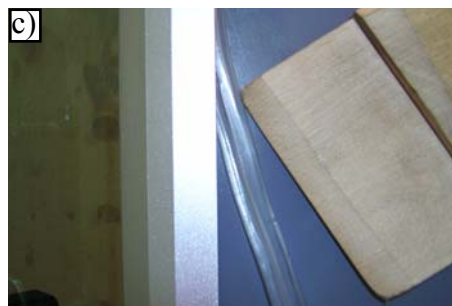
Použít dřevěný klín use the wooden scotch
