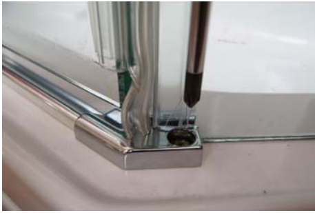
Použít šrouby 3,5x16 use screws 3,5x16
