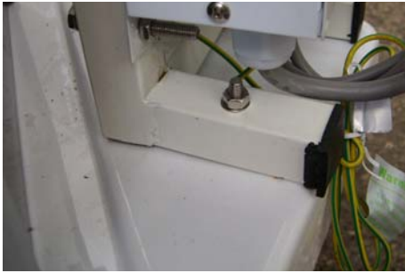
Použít šrouby M6x50 use screws M6x50
