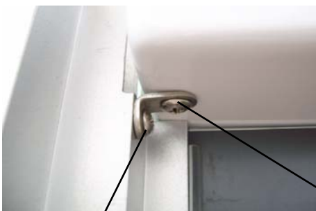
Použit šrouby 4,2x12 Svislé profily spojit se střešou use screws 4,2x12, link the vertical profiles with top panel
